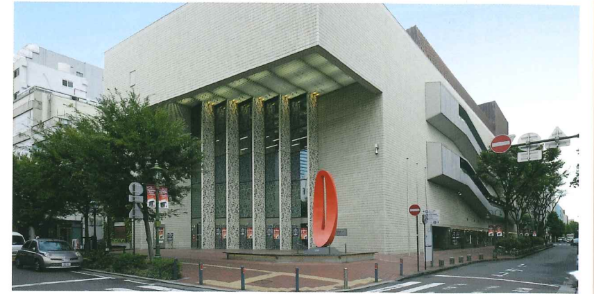
上:外観/下:大ホール
